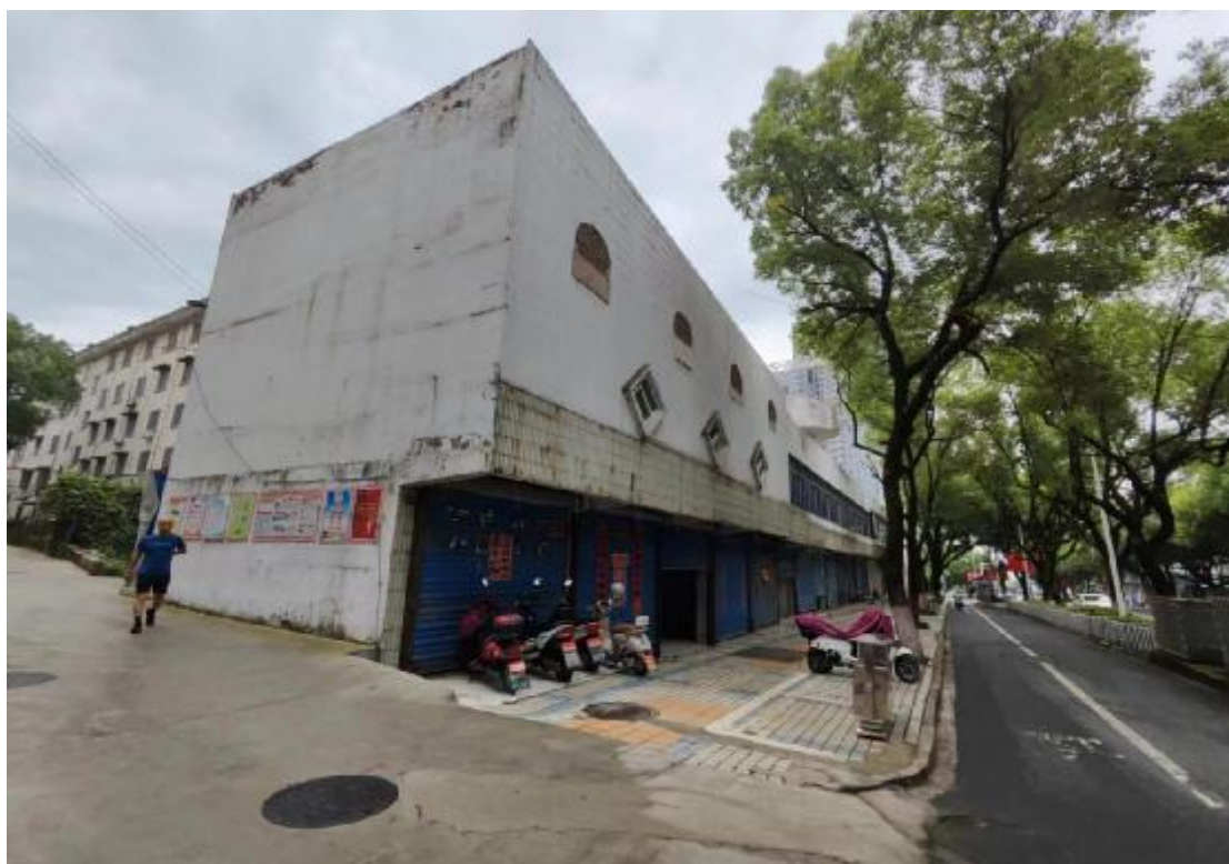
图 1.1 宣城宾馆门面房外观现状
